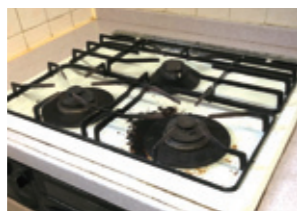
コンロ(工事前)
