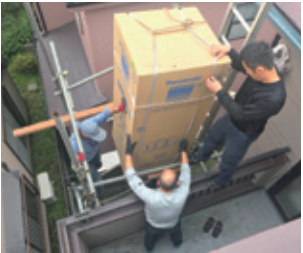
足場を組んで、ギリギリです(汗)。
